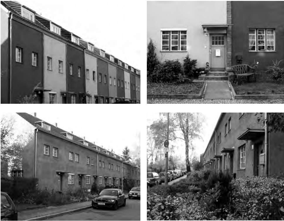
Fig. 5. Großsiedlung Britz. Estado actual. (Fotografía Luca Conti).
